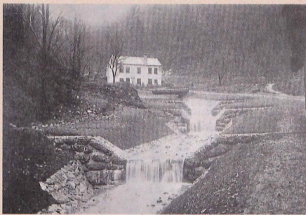
最初に訪れたウィーン郊外リエンフェルトのユングヘルンタール川の砂防
