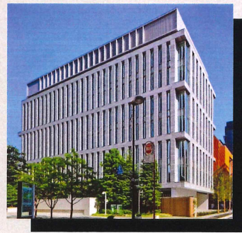
砂防会館新本館
