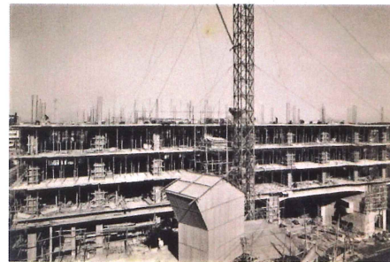
昭和31年11月 工事中の砂防会館
